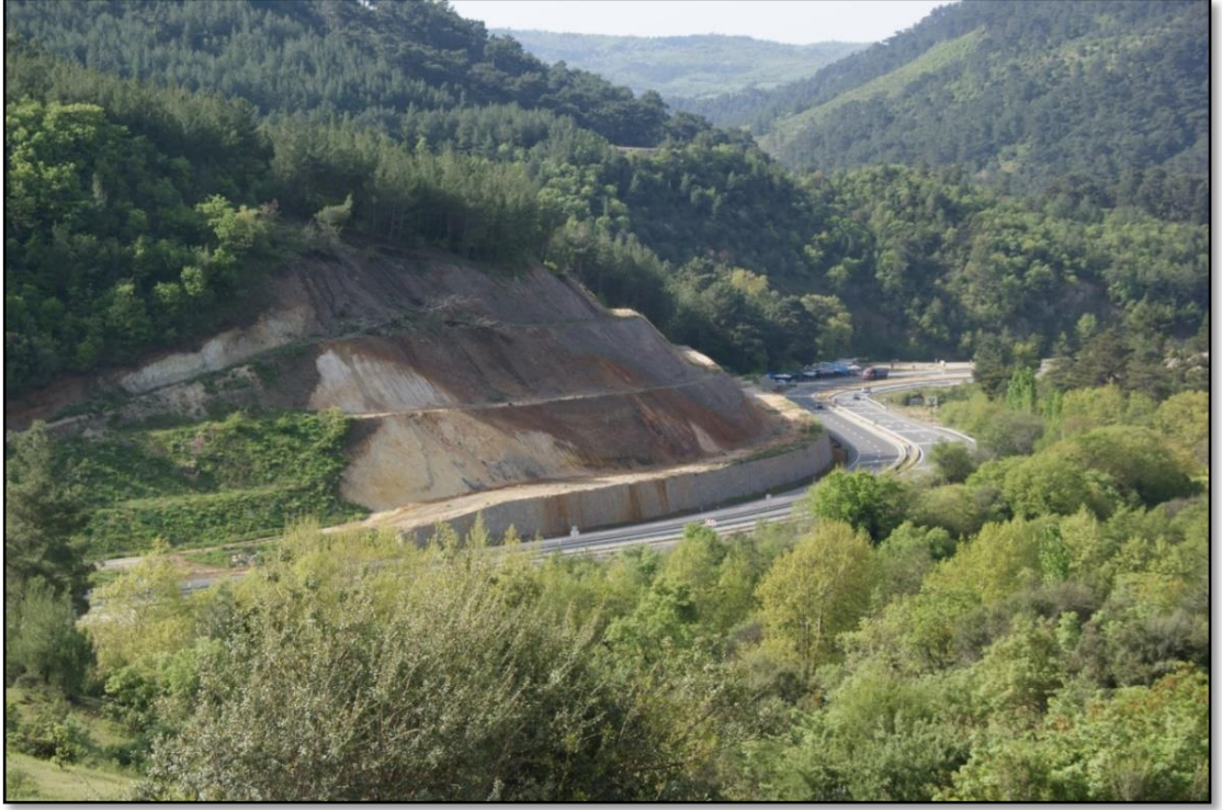
Foto 35. Balıkesir - Edremit Karayolu 62. km'sinde Yamaç Dengesini Korumak Amacıyla Yapılan Teraslamann Görünümü (2015).
