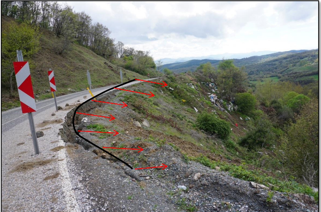
Foto 37. Büyükaşapçı Köyü Yolu Üzerindeki Heyelan. Bu Alanda Eğim Değerleri Yer Yer %45'i Geçmektedir. Bitki Örtüsü ise Tahrip Edilmiştir. Yamaç Gradyanının Bozulduğu Alanlarda Kütle Hareketleri Meydana Gelmektedir.
