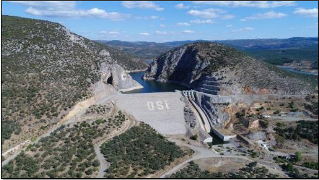
Foto 45. Havran Barajı'ndan Görünüm. ( www.dsi.gov.tr 'den alınmıştır).
