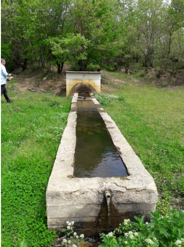
Foto 51: Hisaralan Mahallesi Yolu Üzerinde, Vakıf Değirmeni Yakınlarında Bulunan Yusuf Aydın Çeşmesi (01.05.2019).
