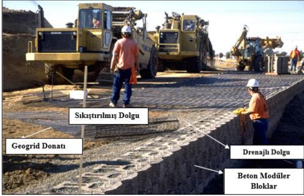
Şekil 3.8: Geosentetik donatılı istinat duvarı elemanları.
