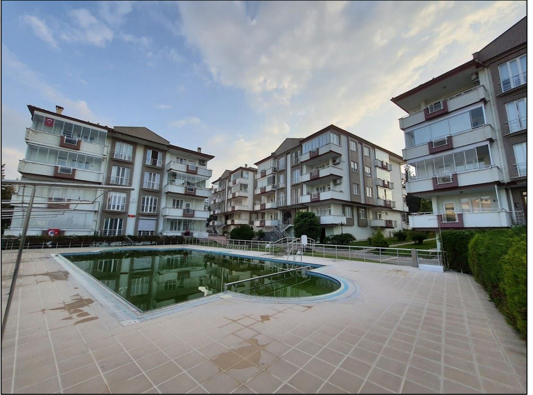
Şekil 5.37: Altın Kent sitesi havuz
