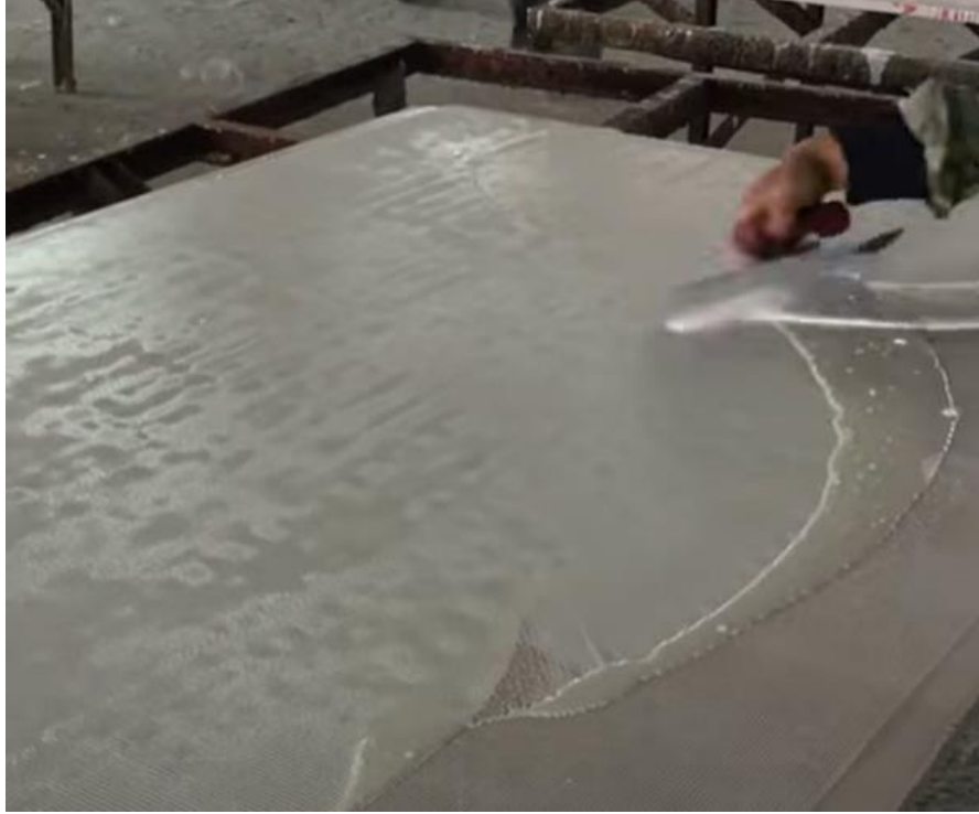
Şekil 1.39: Mala ile ikinci kat epoksileme işlemi yapılan levha örneği.
