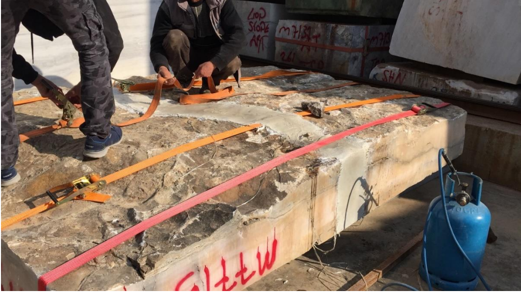
Şekil 1.11: Stok sahasında bohçalama için ön onarım yapılarak birleştirilen blok örneği.
