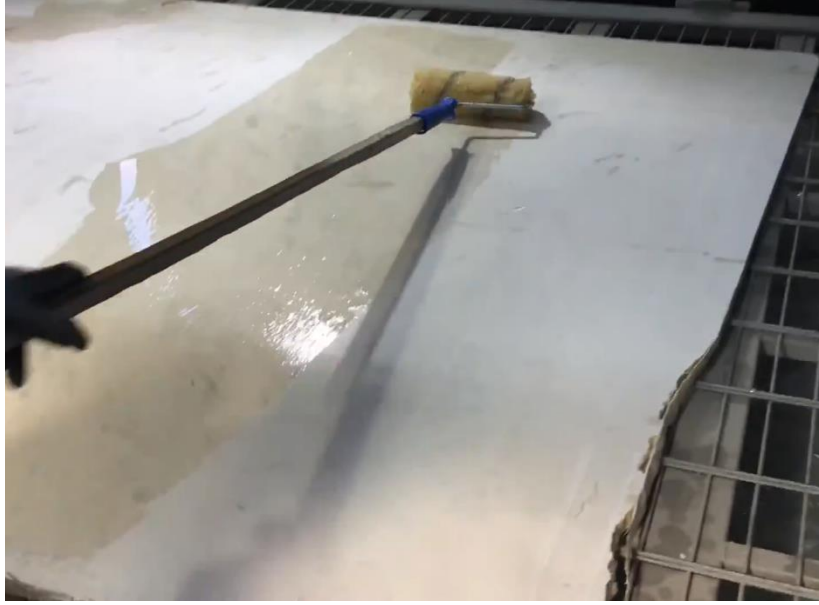
Şekil 1.40: Rulo ile ikinci kat epoksileme yapılma işlemi.
