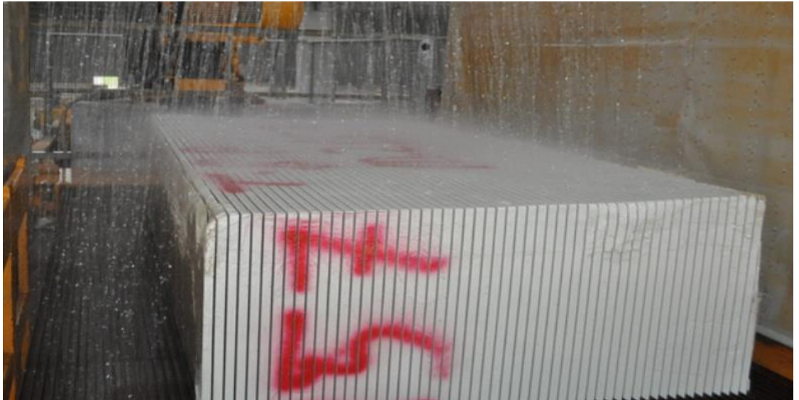
Şekil 3.9: Katrakta kesimi yapılan blok.
