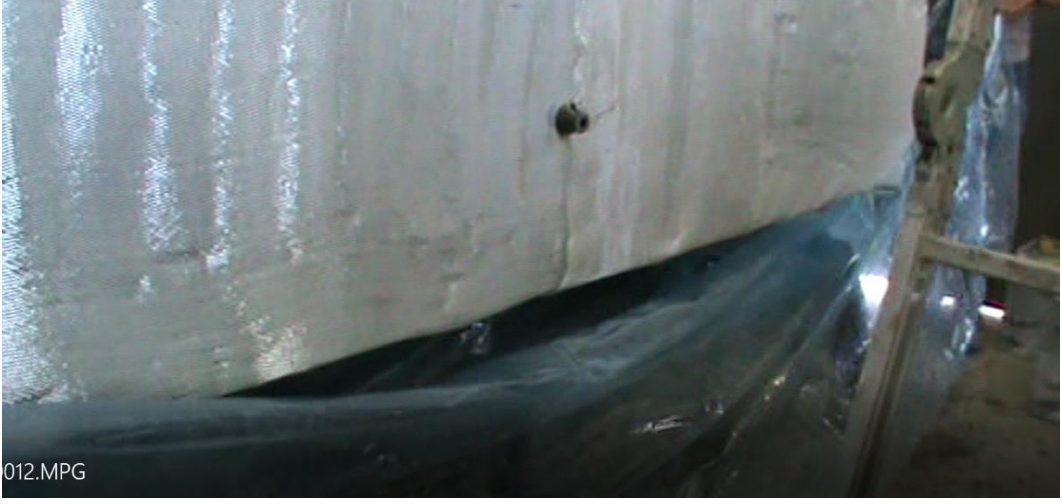
Şekil 1.21: Naylonlama işlemi yapılmaya başlanmış blok örneği.
