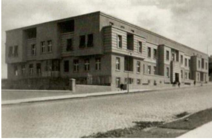
Şekil 3.5: Sayıştay Binası (Atalay Frank,2015)
