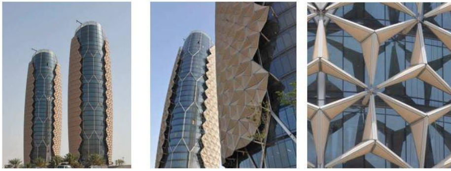
Şekil 5.12: Cephede Güneş Kontrol Elemanları Kullanımı, Al Bahar Towers (Altın & Orhon, 2014)
