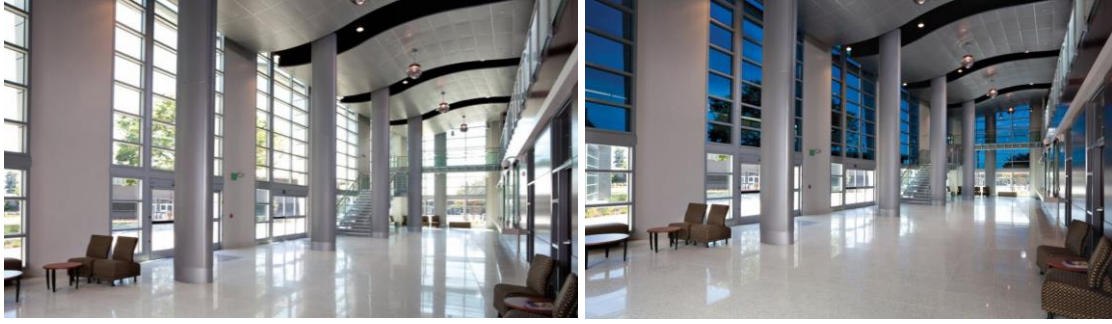
Şekil 4.24: Elektrik Sinyali Öncesi/Sonrası Elektrokromik Cam Örneği (Perker & Akkuş, 2020)
