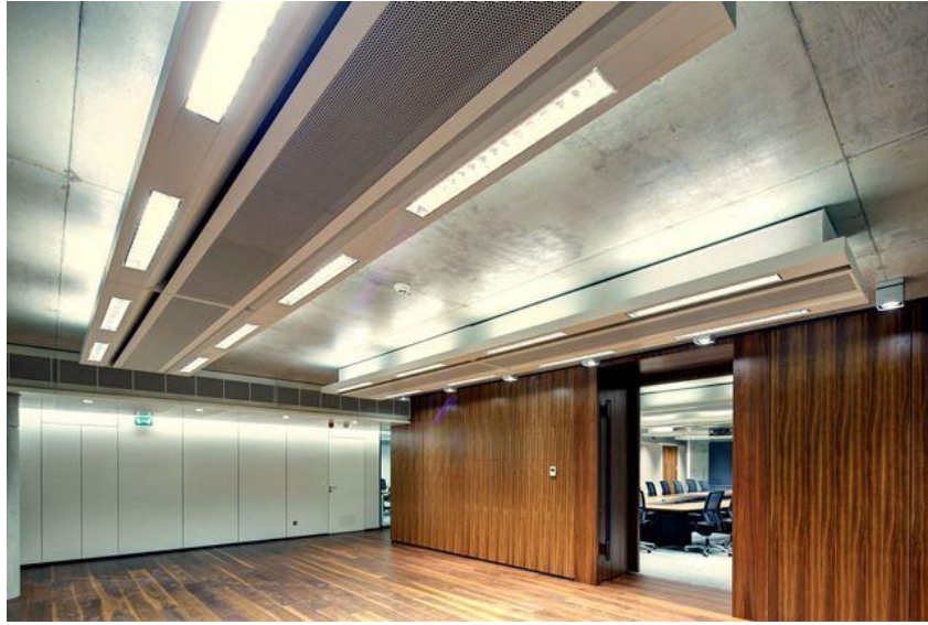
Şekil 5.39: Child Beam Sistemi İç Mekan Görünümü, TMB Merkez Binası (Özkazanç, 2013)
