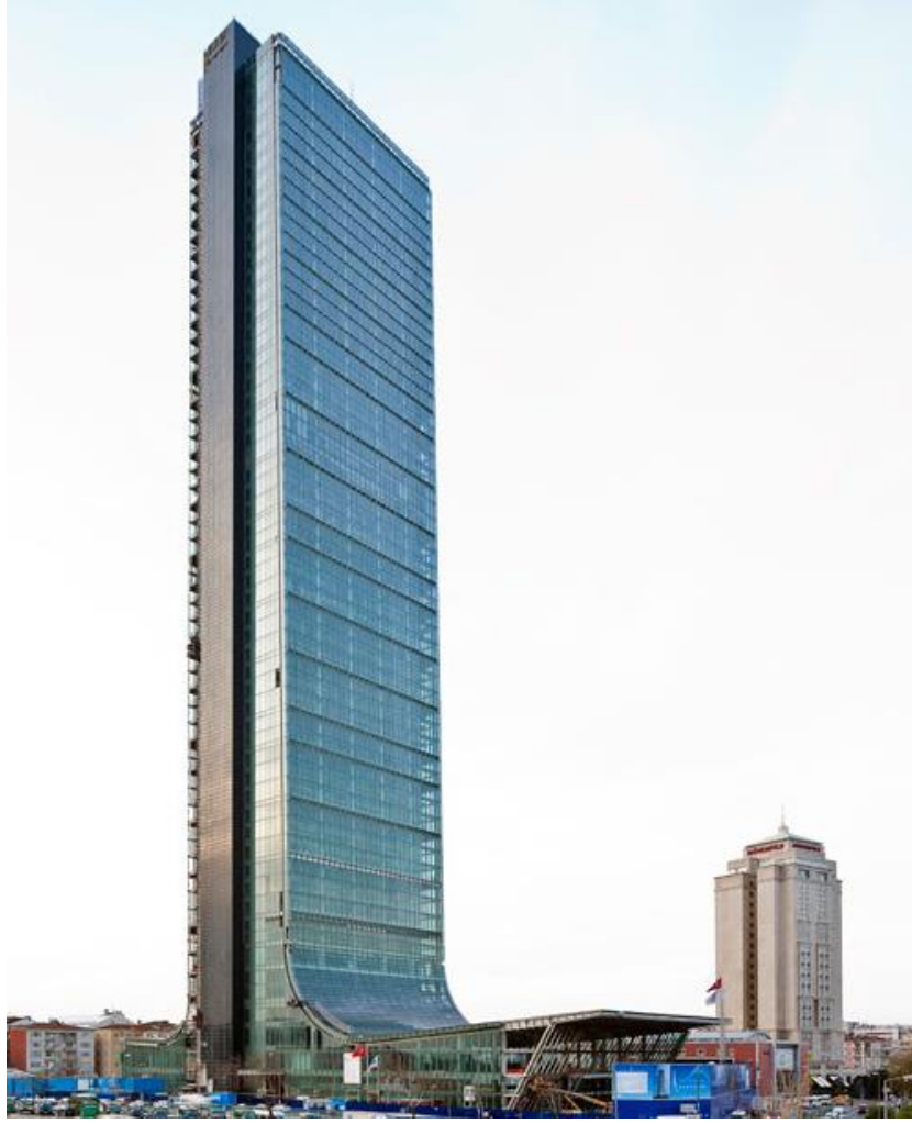
Şekil 5.30: Cephe Görünüşü, İstanbul Sapphire (Germen, 2011)
