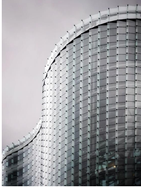
Şekil 5.34: Balık Pulu Düzeninde Yerleştirilen Cephe Elemanları, Maslak No/1 (Maslak No/1, 2014)
