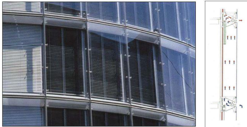
Şekil 4.14: Kutu Tipi Çift Tabaka Cephe Örneği, RWE Binası (Gür N. V., 2007)
