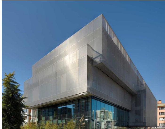
Şekil 5.41: Paslanmaz Çelikten Oluşan Mesh Malzemeli Cephe Tasarımı, TMB Merkez Binası (Özkazanç, 2013)
