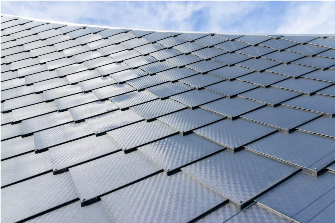
Şekil 5.25: Ejderha Ölçekli Güneş Paneli Birleşim Detayı, Bay View Campus (Baan, 2022)
