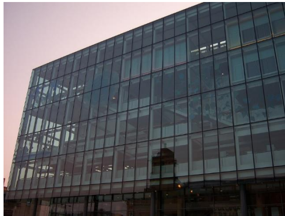
Şekil 4.9: Silikon Cephe Örneği-Newcastle City Library (Wikimedia Commons)
