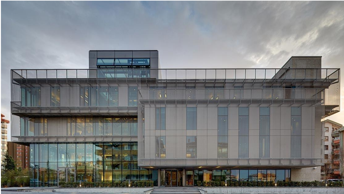
Şekil 5.36: Dış Cephe Görünümü, TMB Merkez Binası (Özkazanç, 2013)
