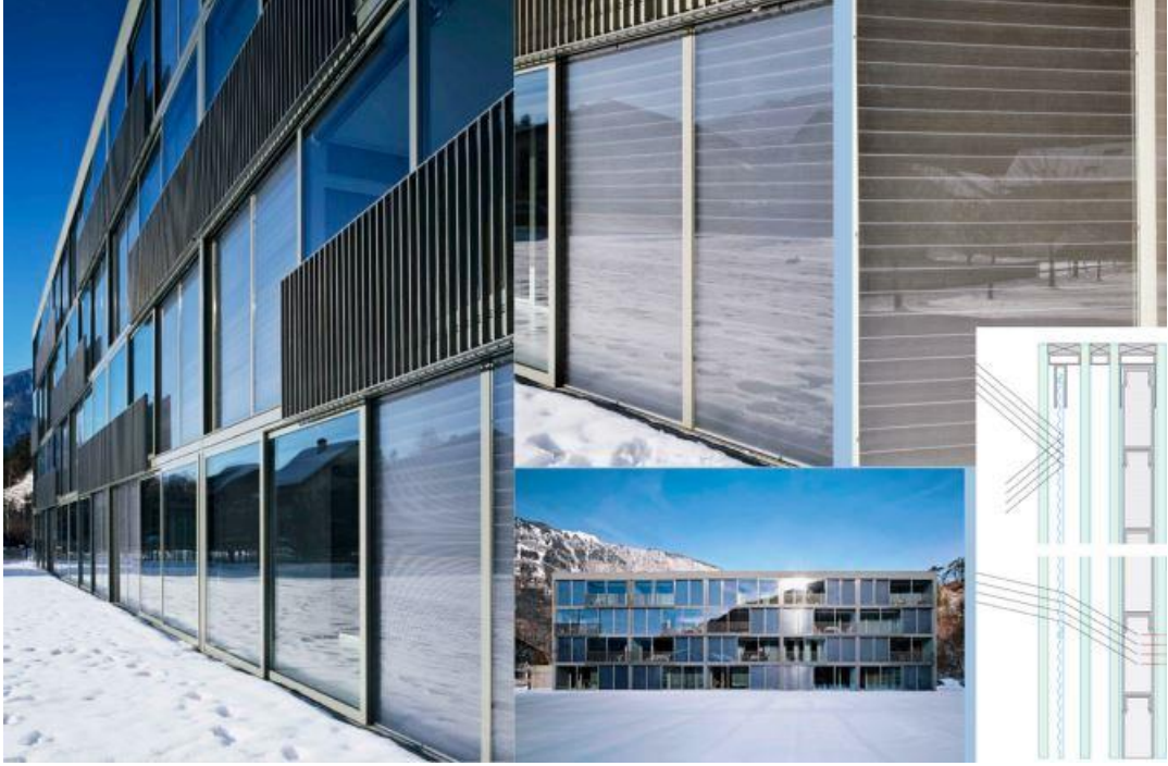
Şekil 4.30: Faz Değiştiren Akıllı Malzeme ile Isı Depolanması, Senior Citizens Apartmanı, İsviçre (van Timmeren, 2009)
