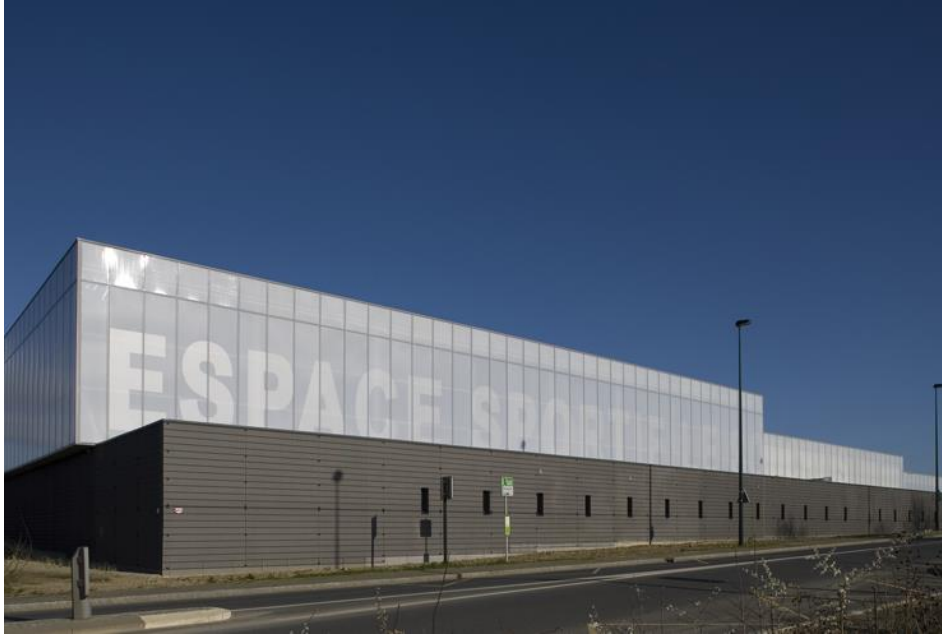
Şekil 5.9: Cephede Arojel Dolgulu Panel Kullanımı, Souchais Spor Kompleksi (Chalmeau, 2022)
