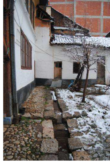
Şekil 3.12: Avlu potokları (Arapi, N. 2012).
