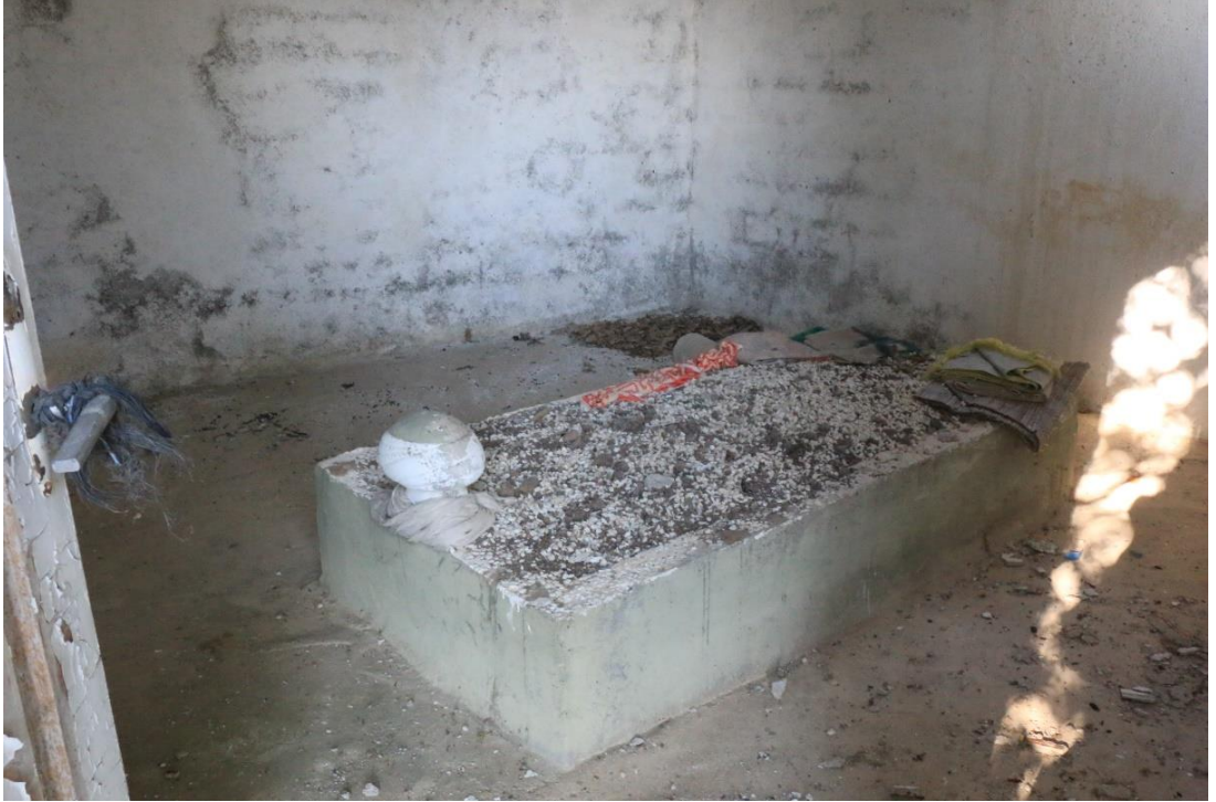
Şekil 26. Karaman Dede Türbesi İç Görünümü
