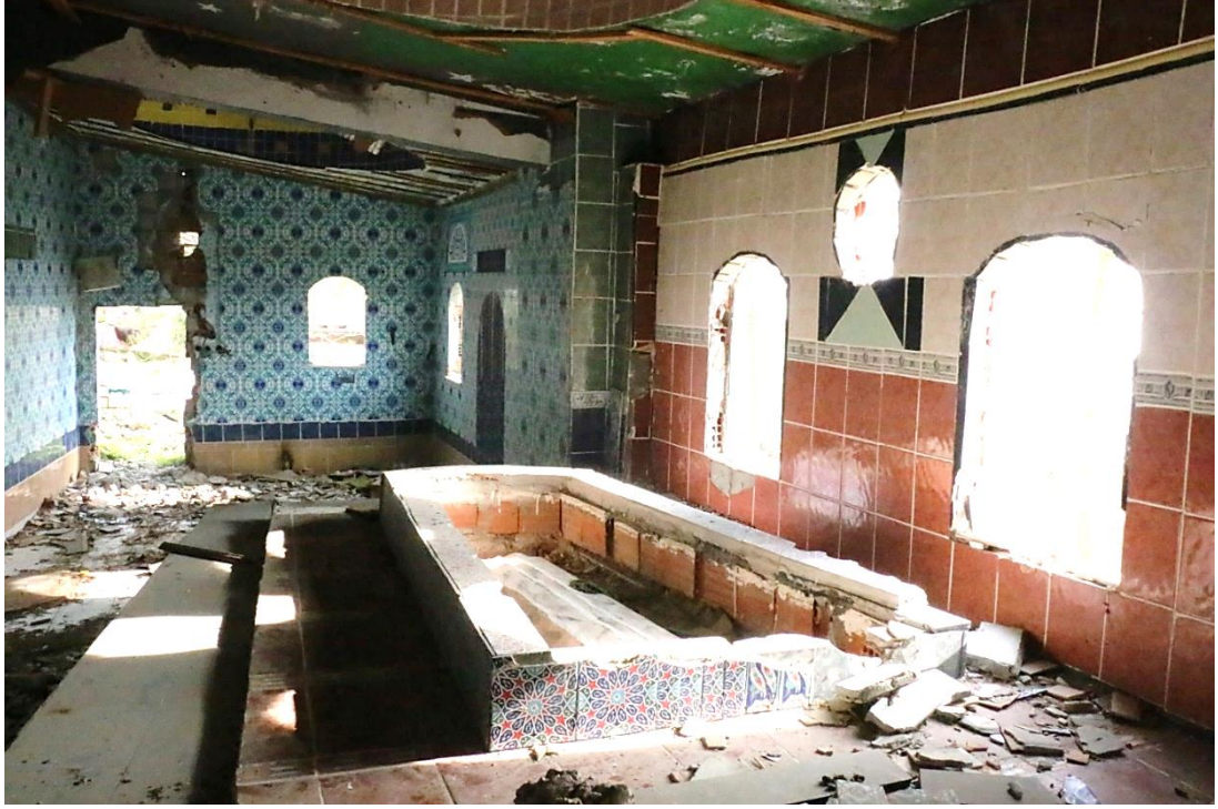
Şekil 72. Gökköy Türbesi İç Görünümü
