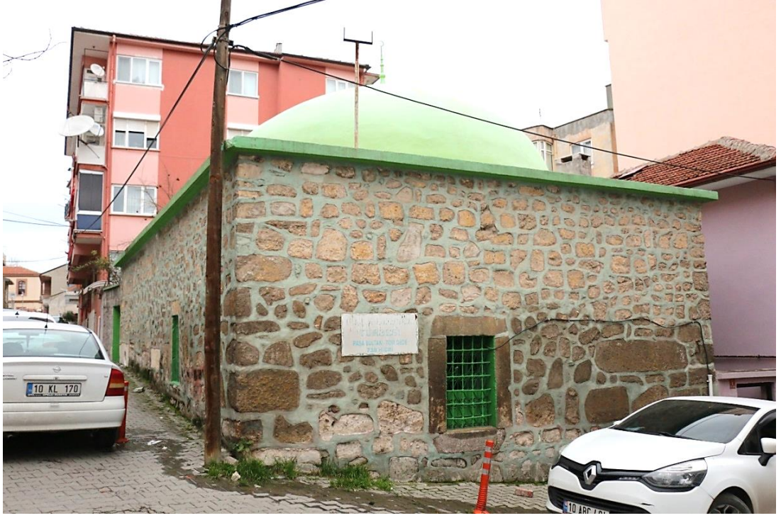
Şekil 6. Paşa Sultan (Töm Dede) Türbesinin Dış Görümü
