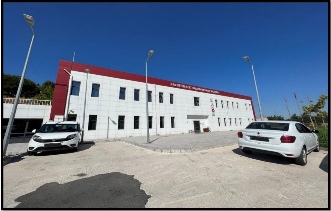
Şekil 78. BBB İtfaiye- Afet Yönetimi'nin Bulunduğu Balıkesir Afet Koordinasyon Merkezi'ne (BAKOM) Ait Bina
