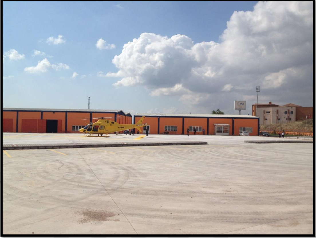
Şekil 77. AFAD Balıkesir Lojistik Deposu (Solda) ve Merkezi (Sağda)
