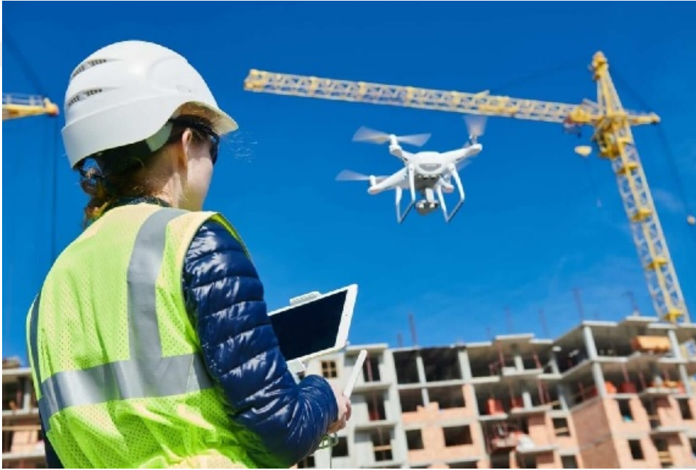
Şekil 2.11: Drone (İHA) ile inşaat denetimi.
