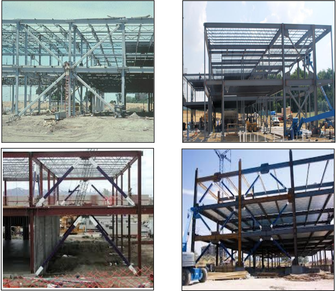
Şekil 1.2: Yaygın kullanılan merkezi çelik çaprazlı perde sistem örnekleri.
