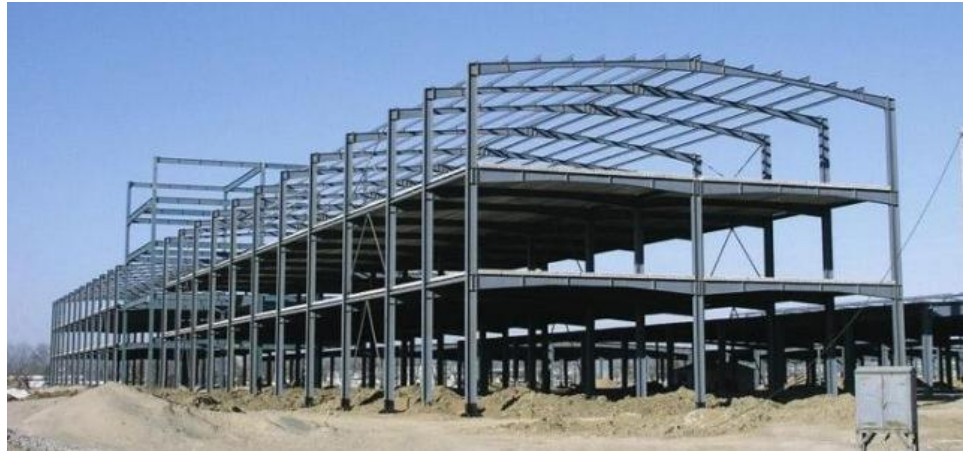
Şekil 1.1: Arakatlı endüstri yapılarına ait taşıyıcı sistemler.
