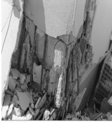
Şekil 2.9 Basınca Çalışan Kolon Donatılarının Ucunda Kanca Yapılması Sonucu Betonda Oluşan Hasar
