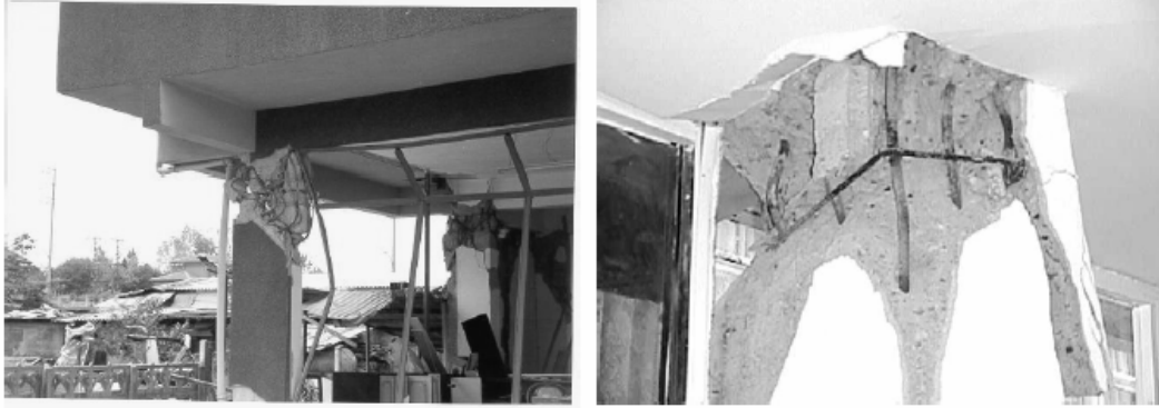
Şekil 2.11 Kolon-Kiriş Birleşiminde Donatı Kusurları
