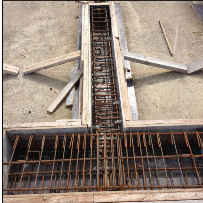
Şekil 4.3: Donatıların kalıba yerleştirilmesi
