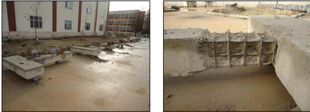
Şekil 4.24: Kabuk betonunun temizlenmesi
