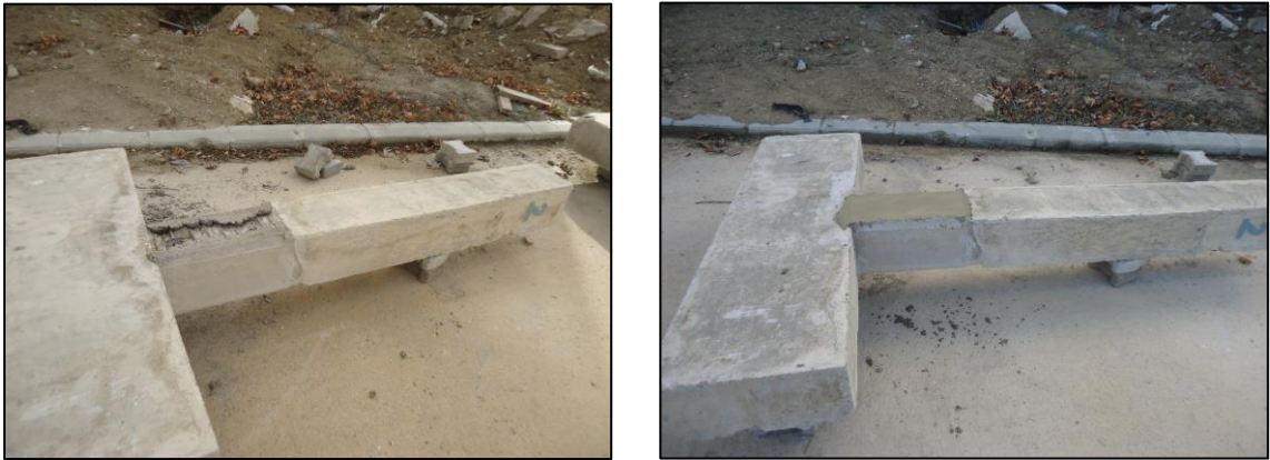
Şekil 4.26: Onarım sırasında oluşan boşlukların doldurulması
