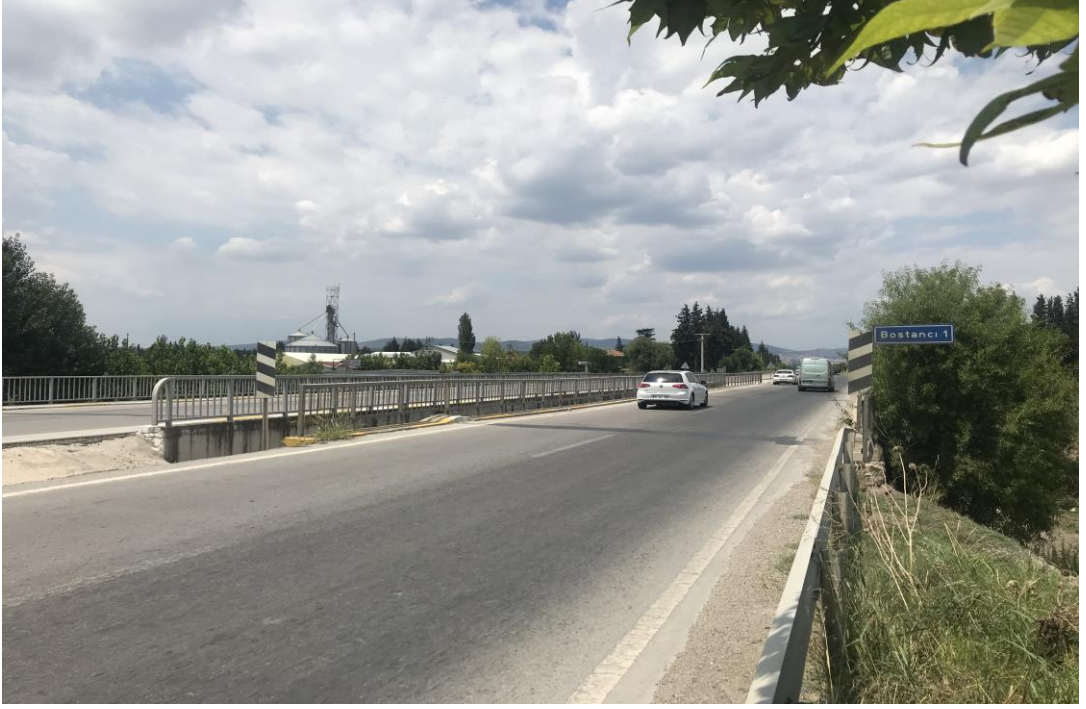
Şekil 4.3: Güzergâh üzerinde bulunan köprülerden Bostancı 1 köprüsü
