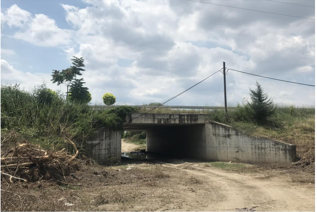
Şekil 4.4: Güzergah üzerinde menfez geçişleri görüntüsü
