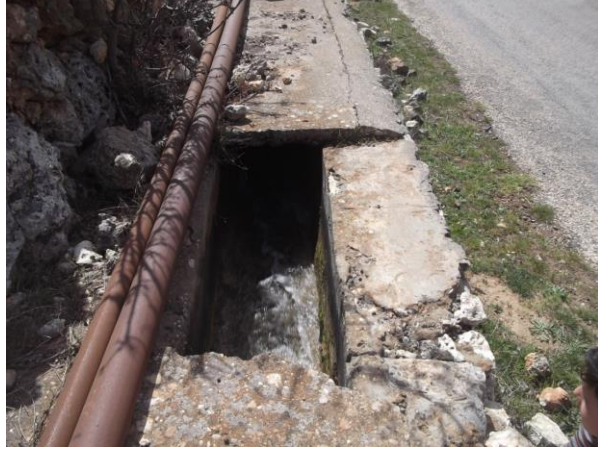
Resim 3.9: Roma döneminden kalan ve halen kullanımda kalan su kanalı. (Örenköy Mahallesi, Silifke)
