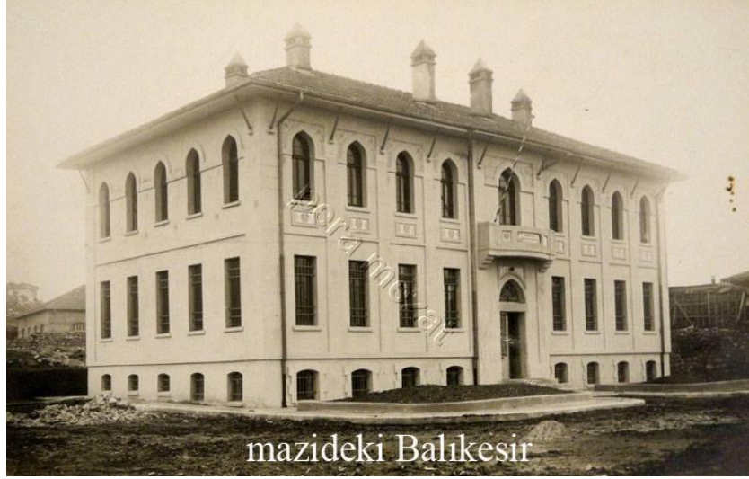
Şekil 4.65: Eski Tekel binası (Mazideki Balıkesir arşivi).
