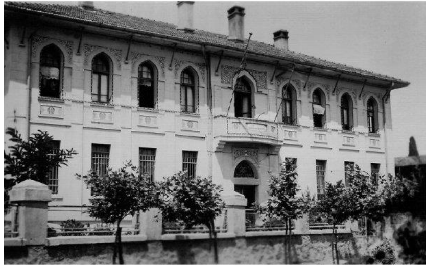
Şekil 4.66: Eski Tekel binası (Mazideki Balıkesir arşivi).
