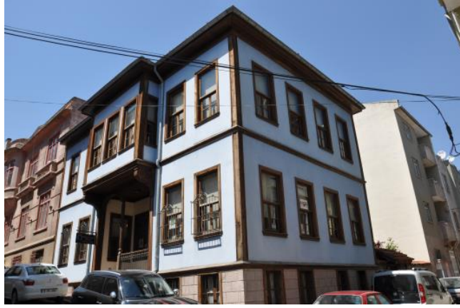
Şekil 4.101: Mimarlar Odası Hizmet Binası (S. Yırcalı arşivi).
