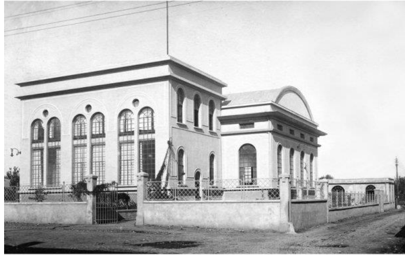
Şekil 4.40: Eski elektrik santrali binası (Mazideki Balıkesir arşivi).
