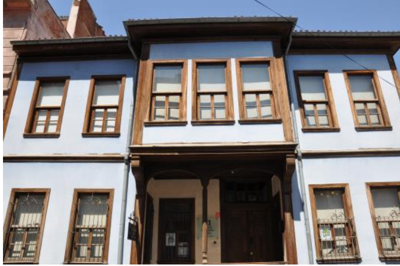
Şekil 4.91: Mimarlar Odası Hizmet Binası (S. Yırcalı arşivi).
