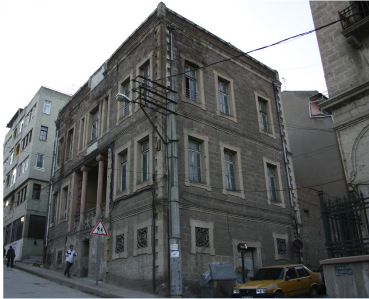
Şekil 4.57: Eski Ziraat Bankası Binası (Cengiz Dikici arşivi).
