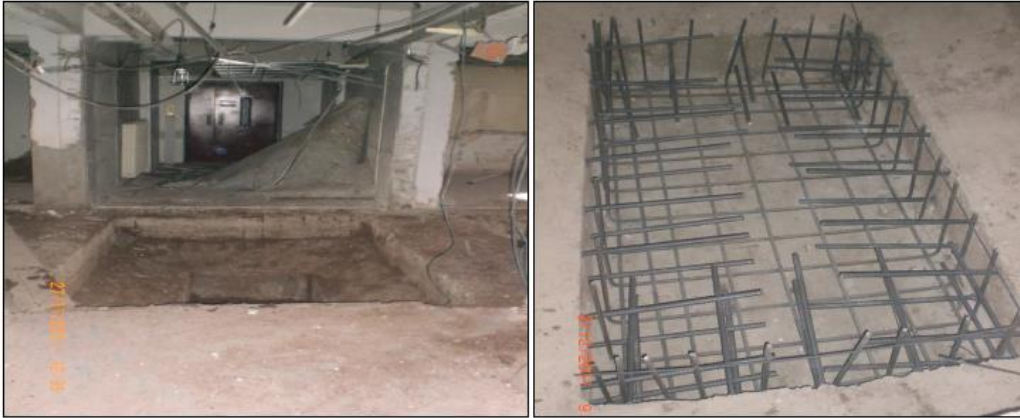
Şekil 6.2: Temelde çukur açılması ve yapılan güçlendirme örneği.
