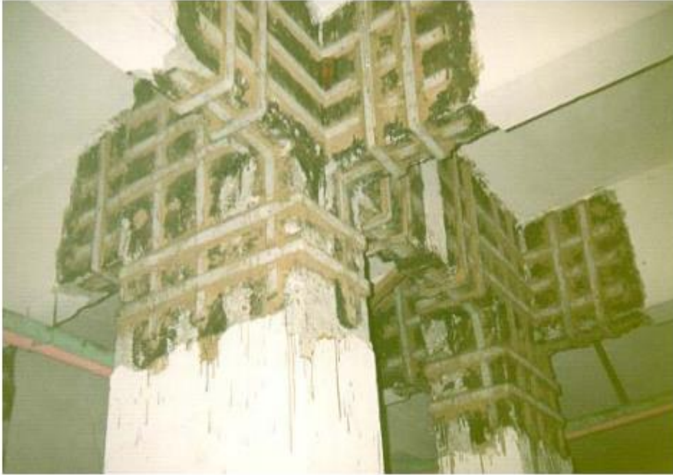
Şekil 6.6: Güçlendirilmiş kolon-kiriş birleşim bölgesi.
