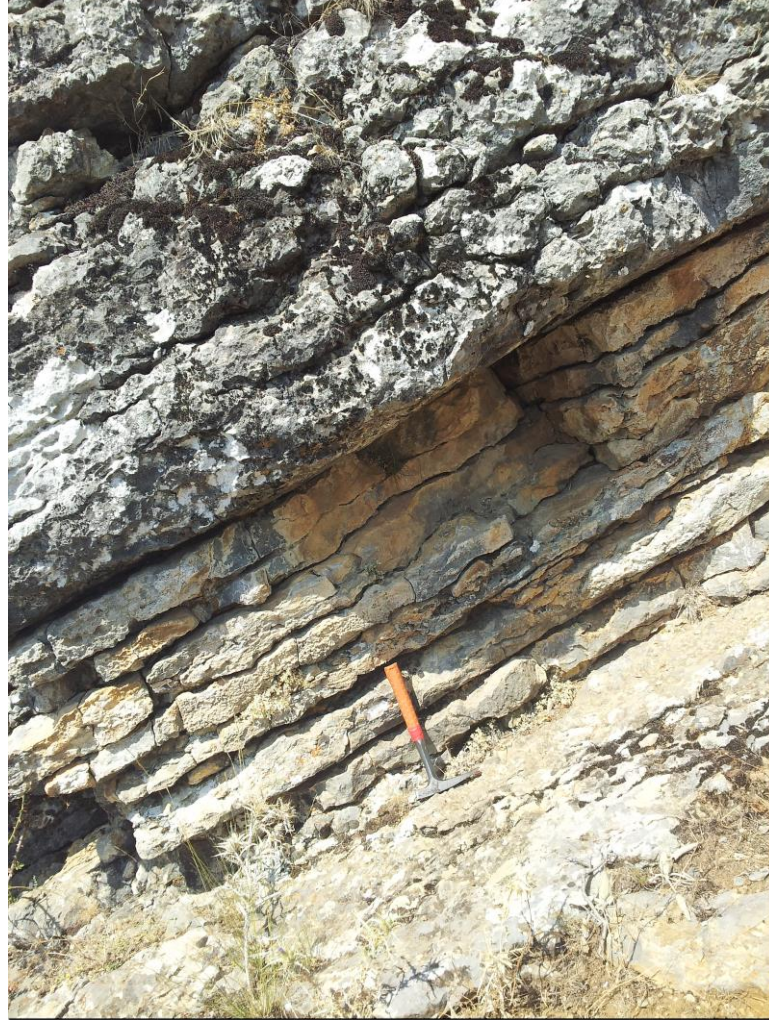
Şekil 4.7: Taraşçı Kireçtaşında gözlenen yumrulu kireçtaşı seviyesinin yakından görünümü (Seydişehir batısı, Taş Ocağı Mevkii güneyi, doğuya bakış).
